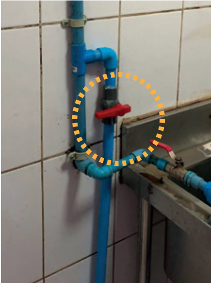
Fig.8 Instalación de llave de bola en tubería de agua producto.
